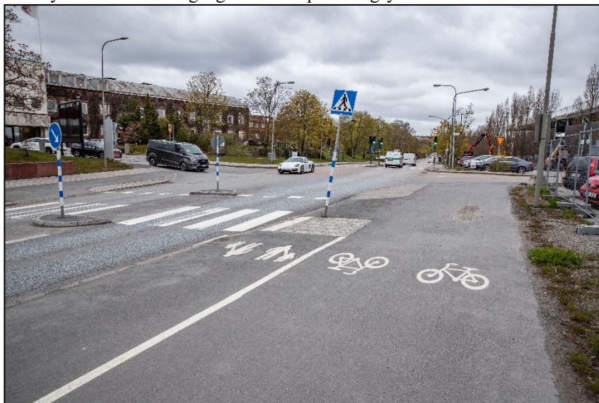
Figur 4, befintlig cykelbana på östra sidan om gatan.
