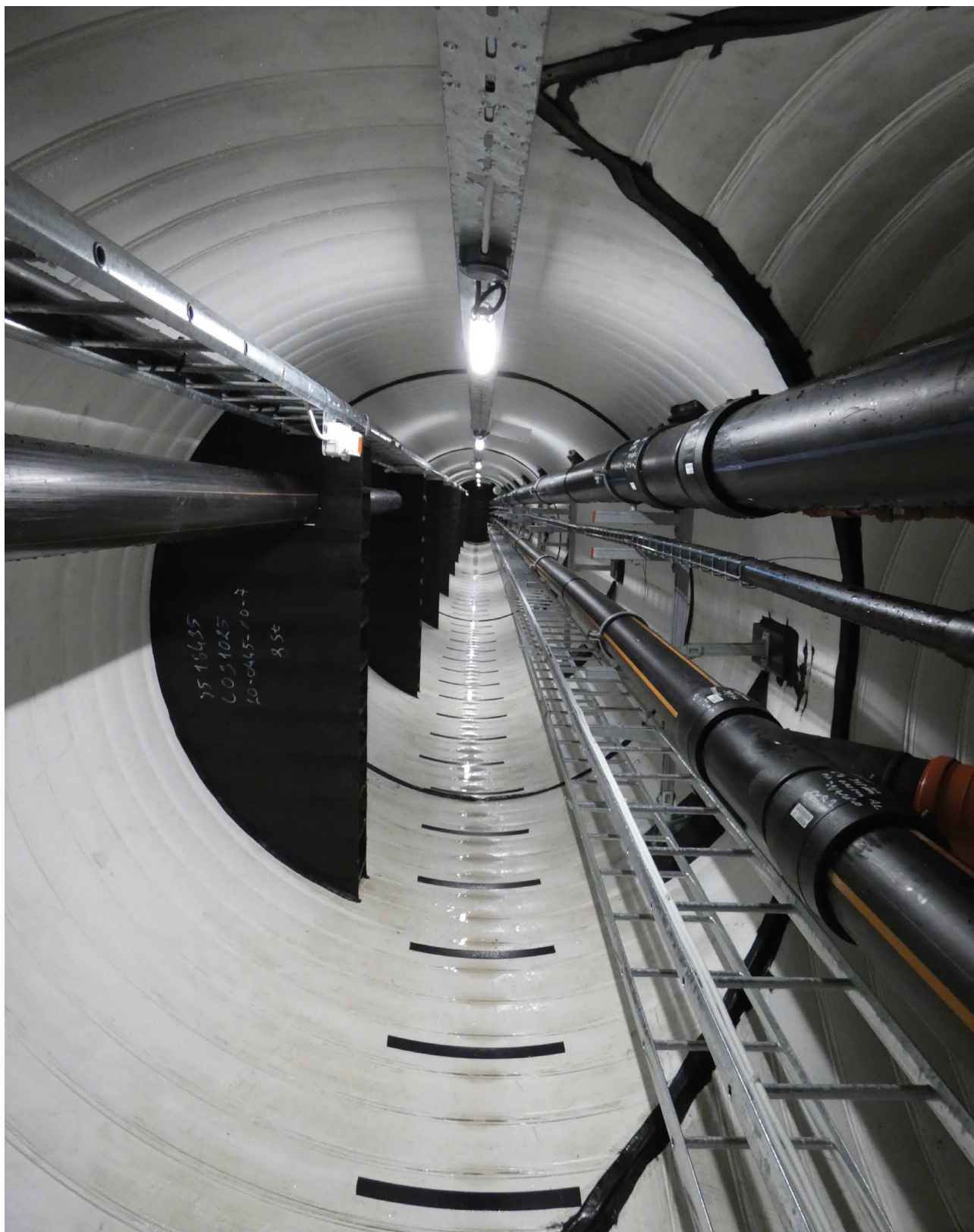
I Södra Häggvik planerar SEOM en infrastruktur-kulvert istället för konventionell ledningsläggning. Metoden kan ge både effektivare byggnation och drift samt ger möjlighet till trädplantering ovanför kulverten.
