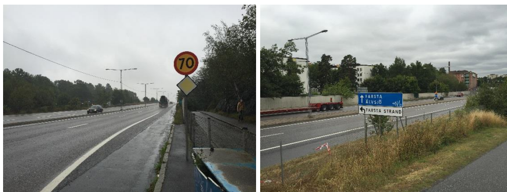
Bild t.v.: Magelungsvägen sedd mot öster, från korsningen med Ullerudsbacken. Bild t.h.: Magelungsvägen sedd mot sydväst, från gångbro över järnvägen.
