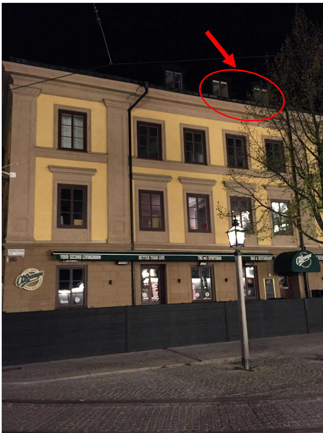
Figur 7: Bild på lägenhetshus sett från Tyrol (bilden är från 2016). Rum som användes för mätning har två fönster och ligger högst upp vid takkonstruktionen, enligt bild ovan.
