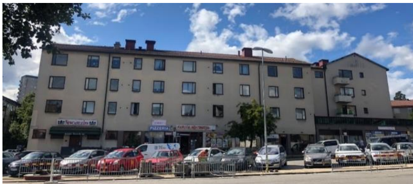
Gatuvy från Lysviksgatan mot kvarterets östra fasad med lokaler i bottenplan och hårdjord förgårdsmark som tillsammans formar ett litet lokalt centrummotiv bortom bilparkeringen. Till höger syns indraget i kvarterets norra hörn över bottenvåningsplanet. (Bild: Vardag)
