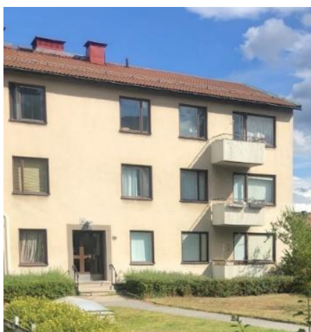
Bilder från bebyggelsen – till vänster mot gården, till höger mot infarten till garaget från öster. Byggnaderna är utförda med fasader i ljus beige ädelputs med fönsterkarmar och portar i brunmålat trä. Utanpåliggande balkonger med räcken av vit sinuskorrigerad plåt. Sadeltak av rött tegel. (Bild: Vardag)
