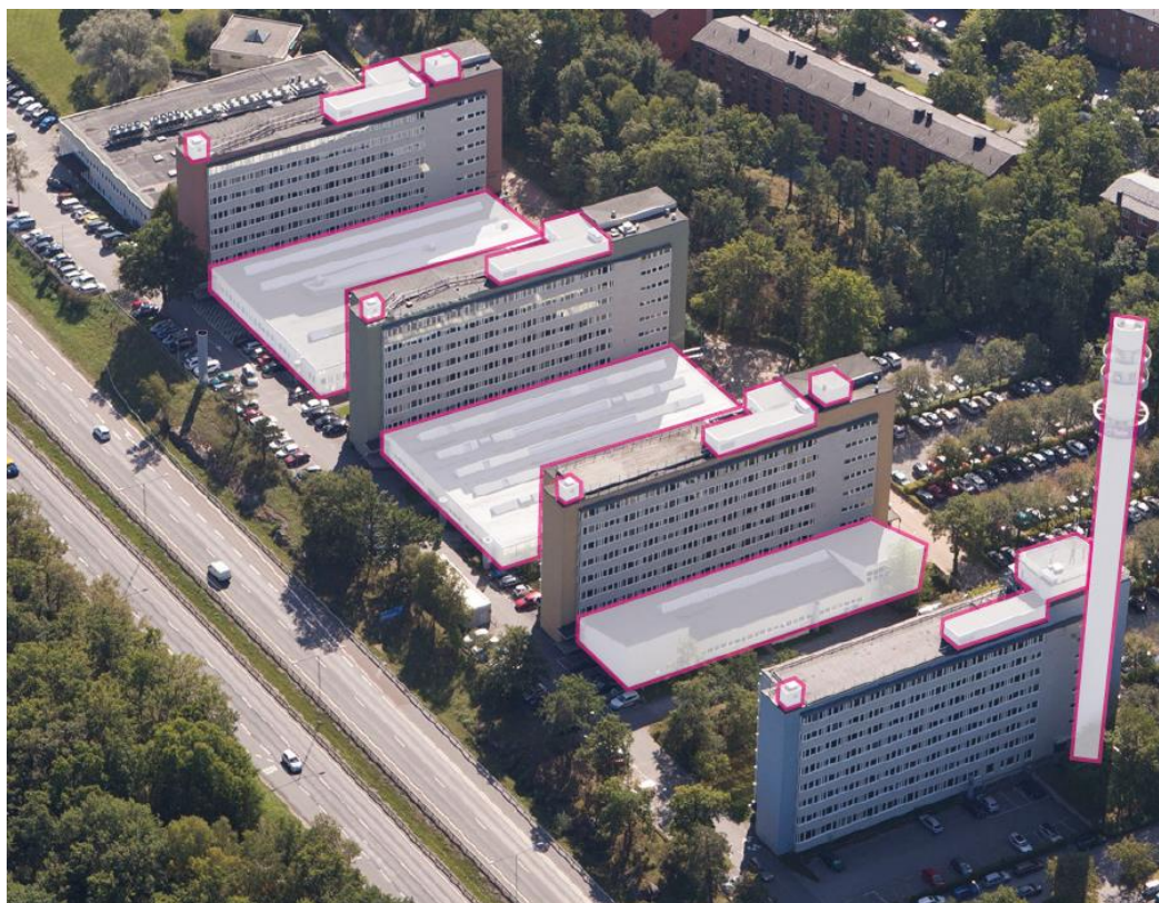
Illustration av de byggnadsdelar som tillåts rivas i detaljplanen; senare tillkomna takpåbyggnader, lågdelar mellan skivhusen och telekommunikationstornet. Skivhusen inklusive ursprungliga högdelar ska däremot bevaras i enlighet med bestämmelsen r2. (Illustration: Christin Svensson Arkitektur)
