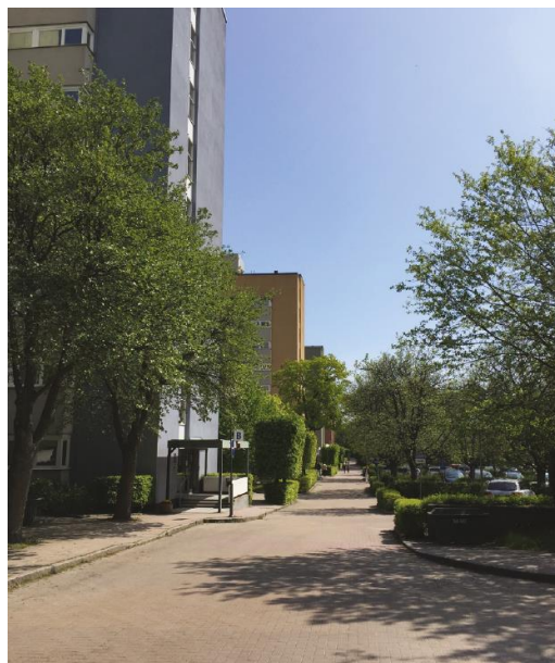
Det stenlagda Vitsandsstråket utmed telelaboratoriets sekvens av skivhusgavlar. Häckar och trädreder förstärker stråkets rumslighet och skärmar av parkeringsytan till höger i bild. Mark- och landskapsgestaltningen är mycket medvetet utförd. (Foto, Nyréns)
