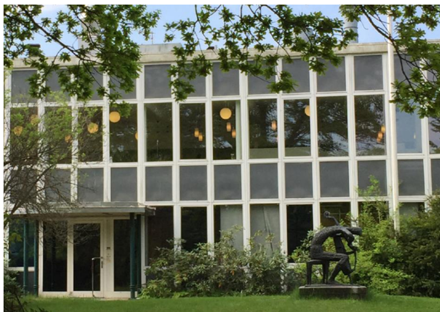
Den före detta matsalsbyggnadens glasfasad av curtain wall-typ som har ett stort kulturmiljövärde och skyddas med bestämmelsen q2.
