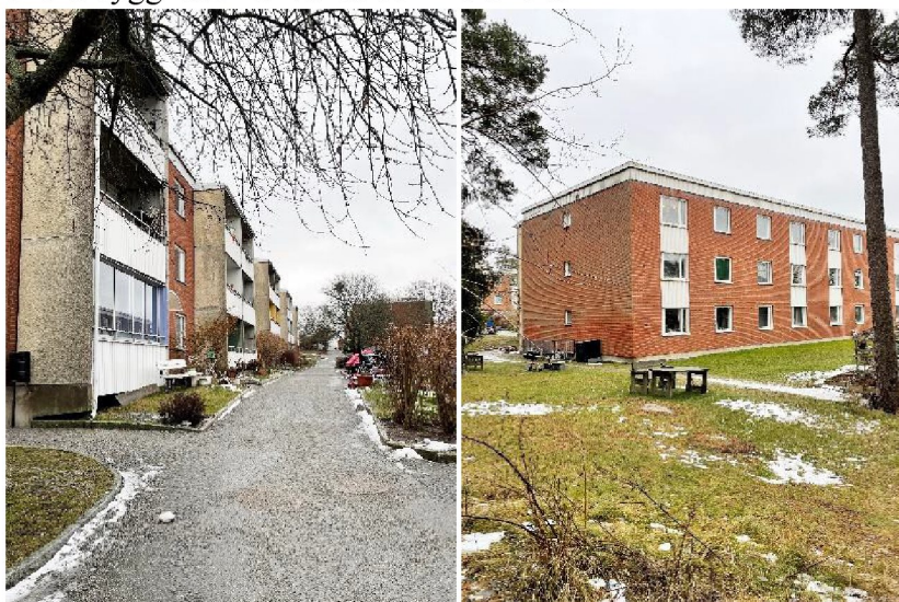
Bild som visar gestaltningen av miljonprogramområdet norr om Byälsvägen (Källa: Esencial Arkitekter).
