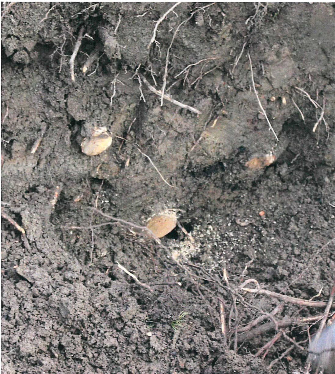
Bild 4. Korrekt beskurna rötter vid schakt.
