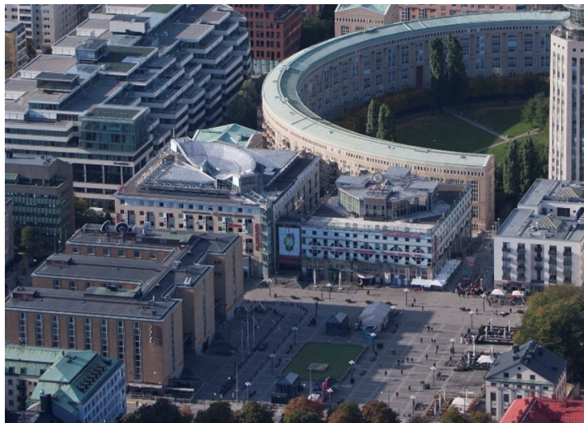
Flygbild från 2018 över befintlig situation. Stadsbyggnadskontoret / Lennart Johansson
