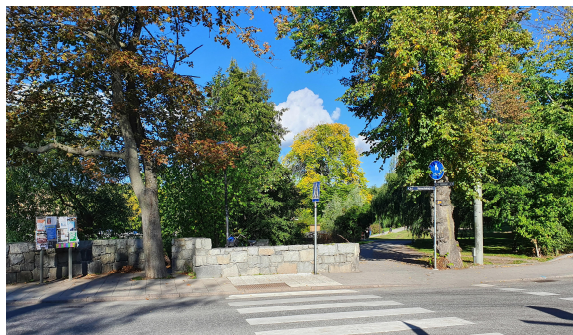
Bild: Befintlig mur vid entrén till Pålsundsparken.
