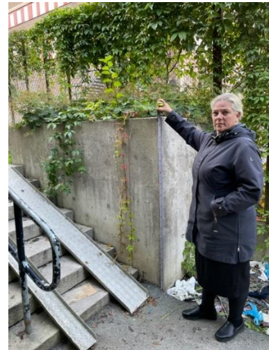
Inmätning av de skilda betongmurarna visar höjder på ca 1 - 1,5 m med vissa lägre delar.
