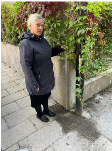
Inmätning av de skilda betongmurarna visar höjder på ca 1 - 1,5 m med vissa lägre delar.
