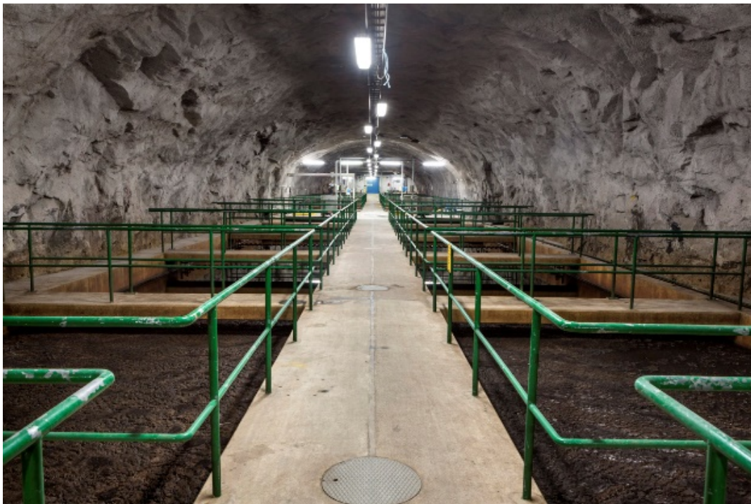
Figur 3 Eftersedimenteringsbassäng innan ombyggnad
