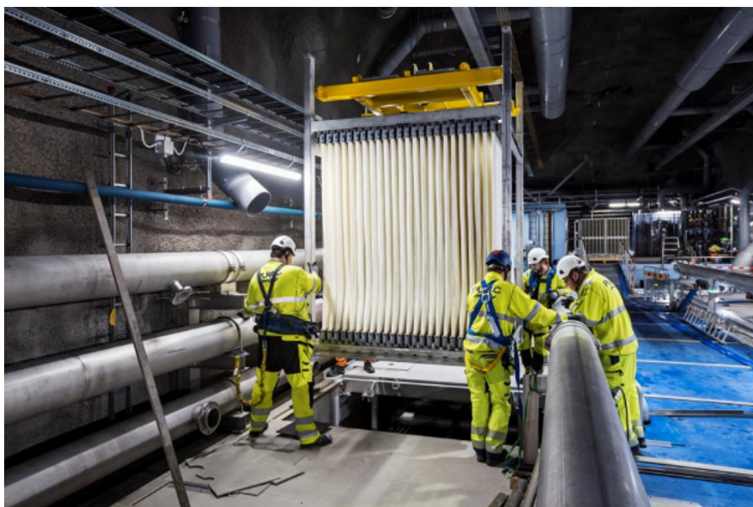
Figur 5 Montage av MBR-kassetter
