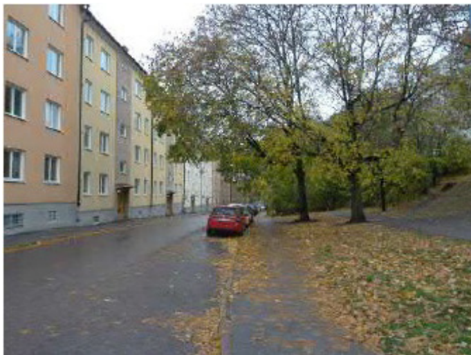
Anslutande lamellhus vid Hövdingagatan.
