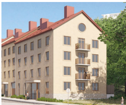
Perspektivbild redovisande möjlig utformning av gavel på ny bebyggelse längs Blommensbergsvägen (delområde A). Bild: Arkitema
