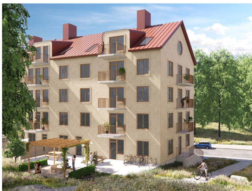
Perspektivbild redovisande möjlig utformning av ny bebyggelse inom delområde A och anslutande bostadsgård. I förgrunden illustreras föreslaget släpp/gångstråk mellan byggnaderna inom delområde A och B. Bild: Arkitema
