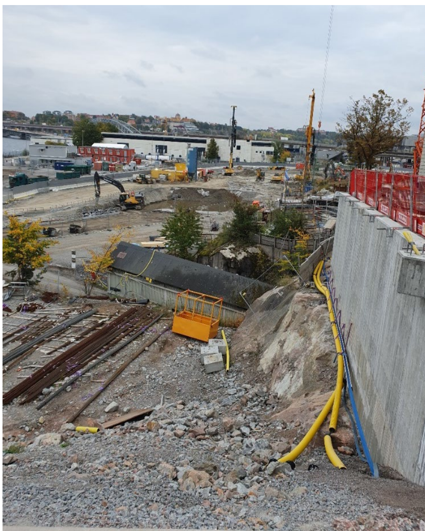
Stödmur mellan planområdet och Gasverksvägen, bilder från hösten 2021
