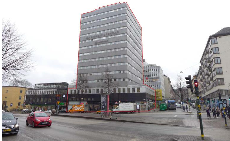
Läkarhuset inom Spelbomskan 9 idag (byggnad inom röd figur), sett från norr/Norrtullsgatan. Notera att bilden är tagen innan skyddsåtgärder på fasad uppfördes. Reichmann Antikvarier 2024
