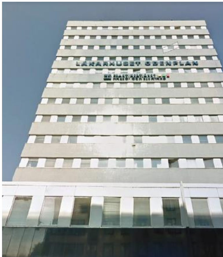
Läkarhuset, befintlig byggnad och dess materialitet och ljusreflektering. Bild: White 2022
