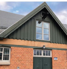
Tidigare takkupa med travers.
