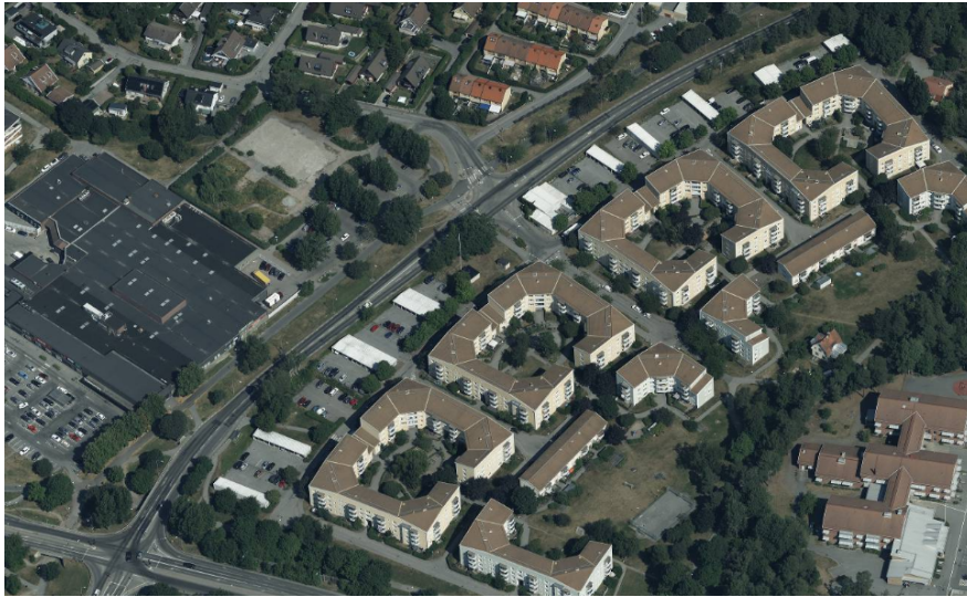
Markparkering i anslutning till Växthusvägen.
