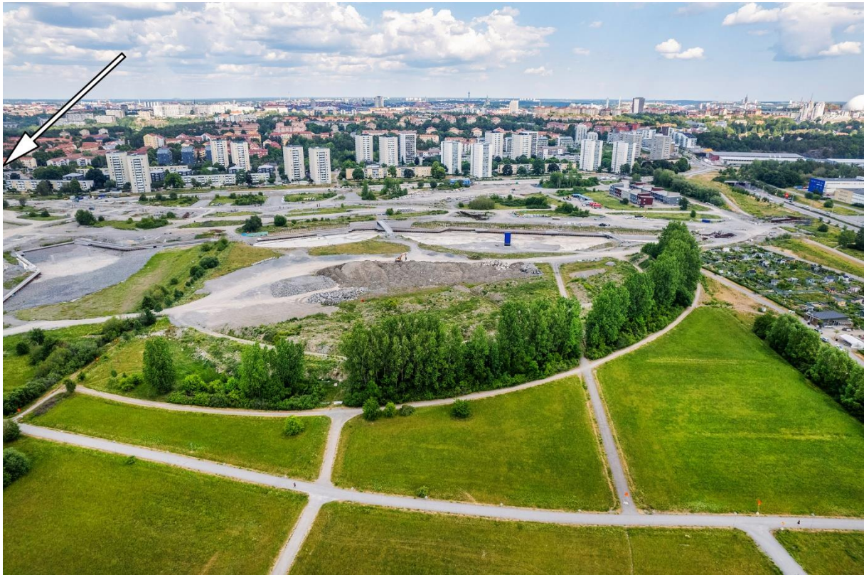
Figur 22. Stora delar av Årstafältet är idag en byggarbetsplats. Den nya tunnelbanestationen kommer att ligga i ett nytt kvarter, nära den befintliga bebyggelse som syns i fotots övre vänstra kant, se vit pil i fotot.
