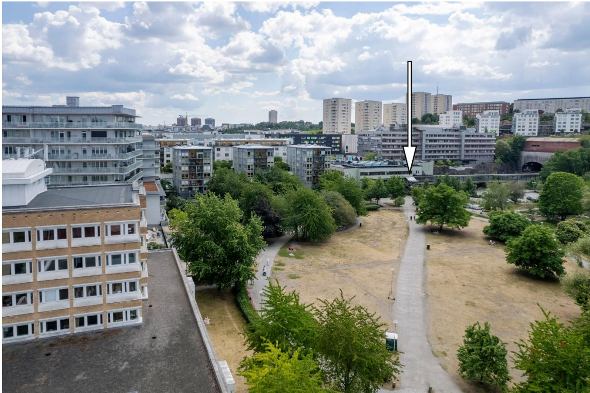
Figur 17. Station Liljeholmen med närområde. Bilden visar Trekantsparken i riktning mot den befintliga tunnelbanestationen. Den nya stationen byggs i anslutning till den befintliga. Läget är markerat med vit pil.
