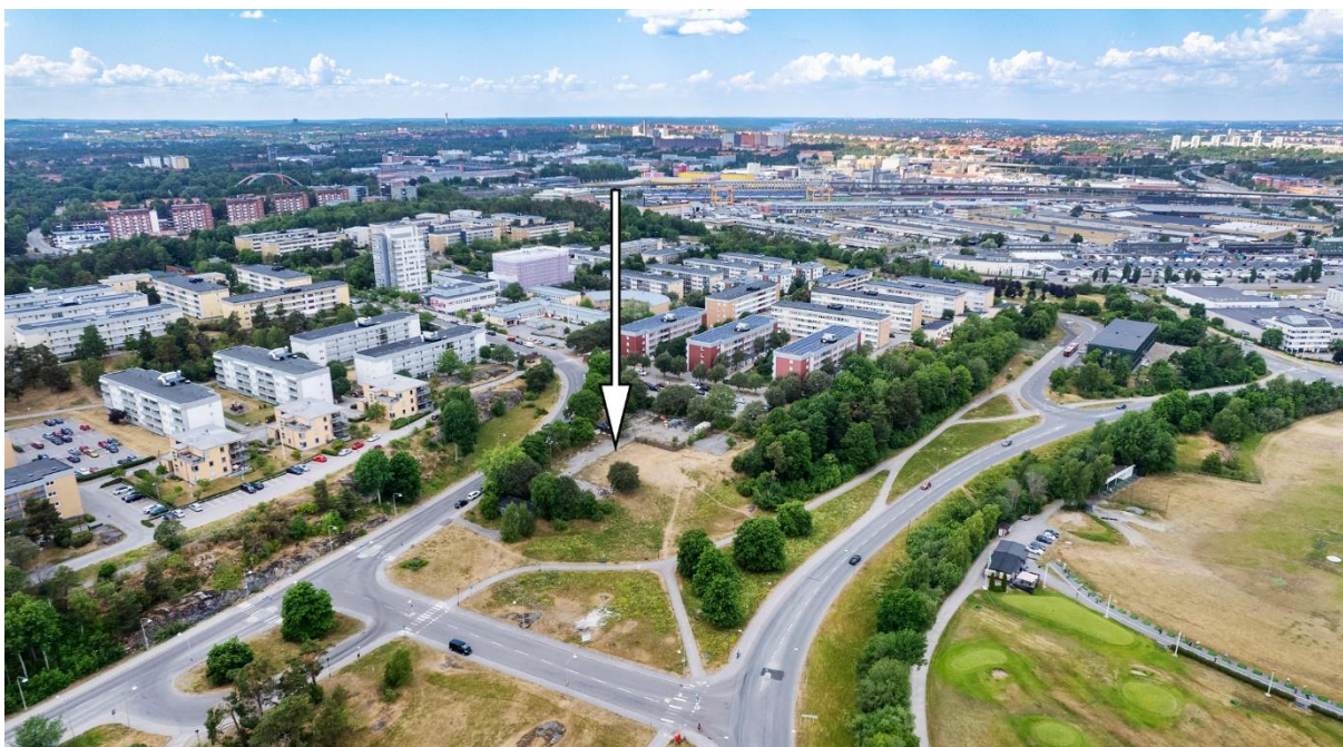
Figur 24. Östberga till vänster i bild, med Årstafältet till höger. Den nya tunnelbanestationen, station Östbergahöjden, kommer att ligga i närheten av bilparkeringen mitt i bilden. Läget är markerat med vit pil.
