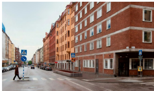
Luftutbytesschakt vid Fleminggatan. Källa:FUT
