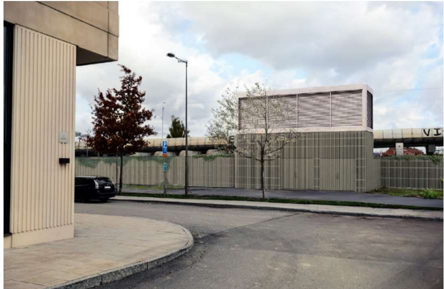
Integrerad överbyggnad för brandgasschakt på Årsta Skolgränd, skärm mot spår område. Källa: FUT
