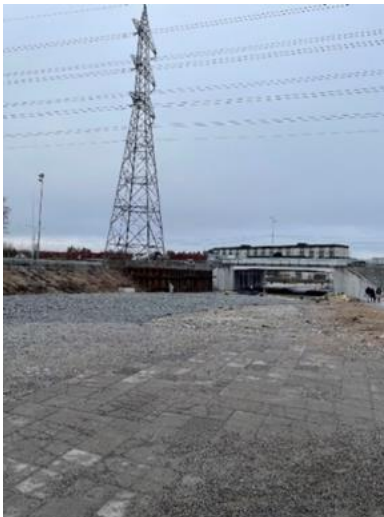
Yta vid Arne Beurlings torg före åtgärder.
