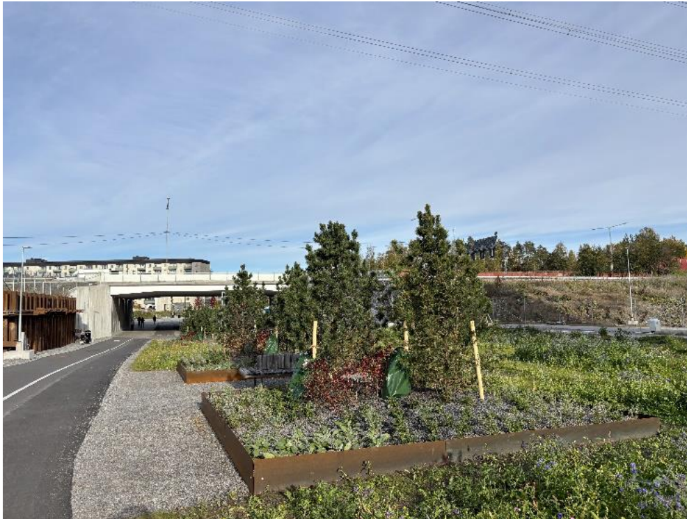
Yta vid Arne Beurlings torg efter åtgärder, augusti 2025.
