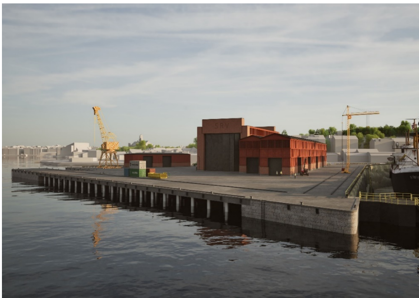
Södra kajen på västra Beckholmen utförs som ett pelardäck i betong mellan fundament med skoning i natursten.
