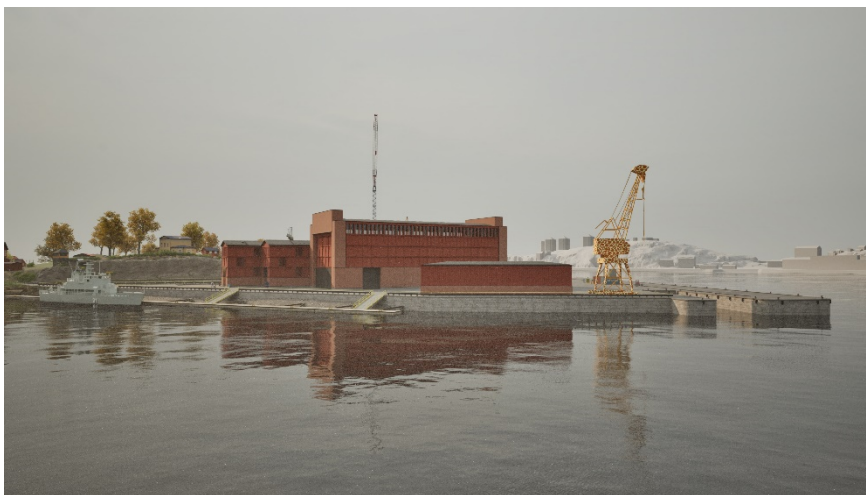
Strandskoning mot Beckholmssundet utförs med stenskodd kaj i kombination med en slänt med stenar, mot väster stenskodd kaj och shipliften till höger, kajens hörn har givits en lugn avrundad form.
