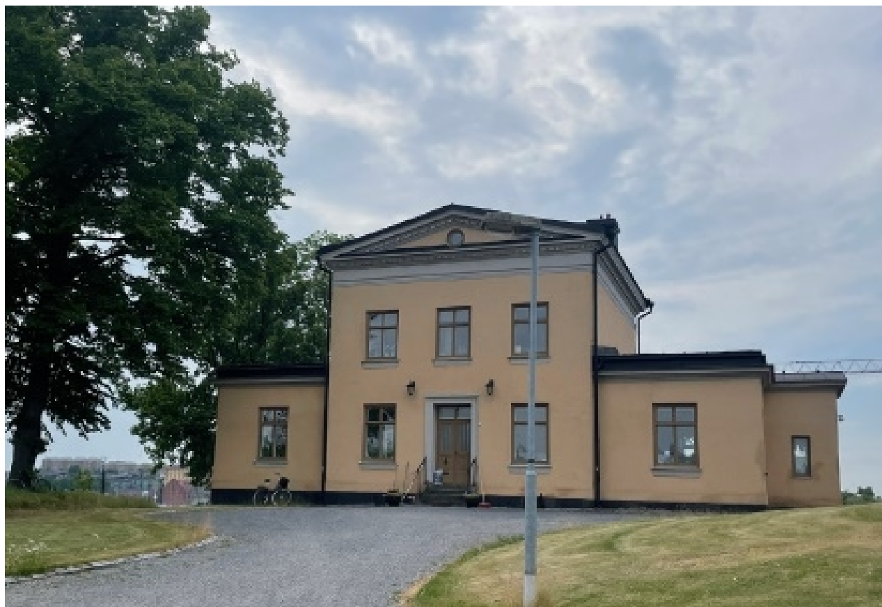
Stenvillan, uppförd för dockmästaren. Källa: Sweco
