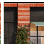
Fönsterpartier bottenvåning ca NCS: 7502-Y - 8502-Y
