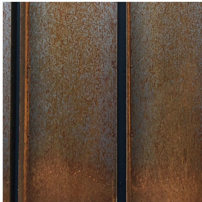
fasaddetaljer i cortenstål
