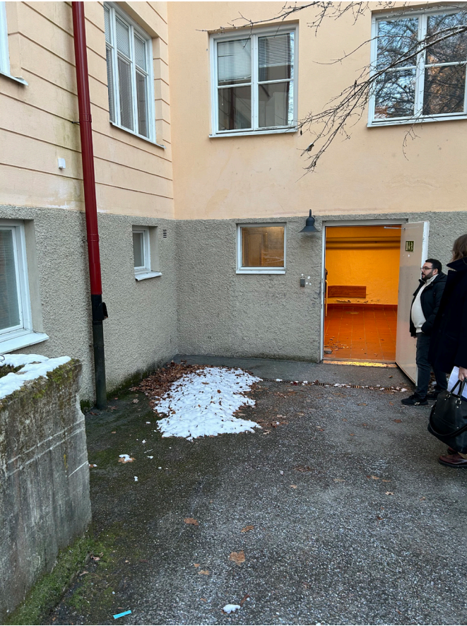
Nedfarten till källaren leder idag in till soprummet.
