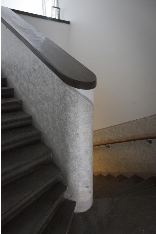
Trapphus. Vilplan mellan 1 och 2 trappor. Trappor och överliggare av kalksten. SSMDIG024246.
