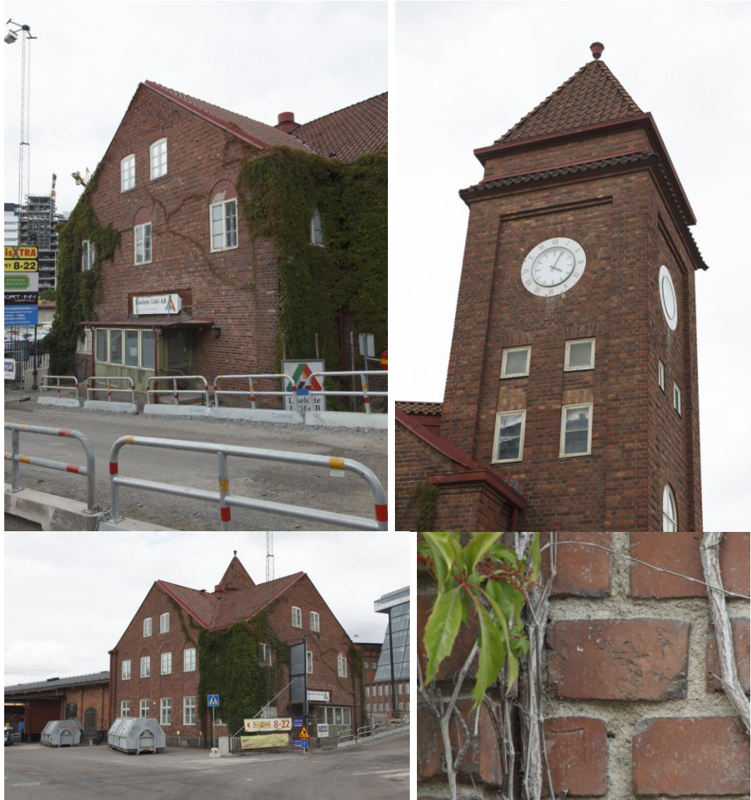
Ovan t v: Västra gaveln med entrébyggnad. SSMDIG024254.
