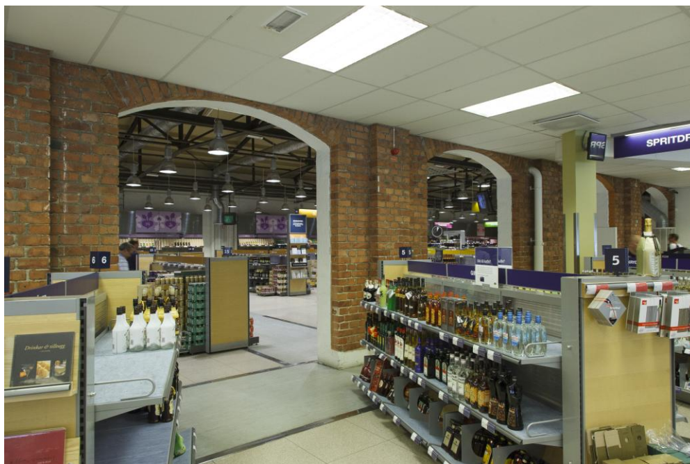
Systembolaget. Norra magasinets ytterväggar och lastportar framträder bland butikshyllorna. SSMDIG024238.
