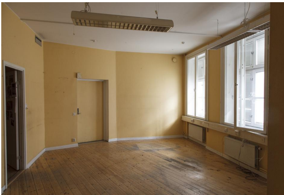
Rum 221, kontor i f.d. stinsens kontor. Sekundära innerfönster. Äldre trägolv av slipade och lackade bräder. SSMDIG024221
