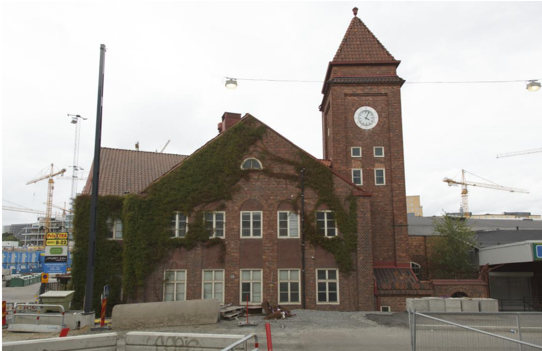
Klockhuset från söder. SSMDIG024252.
