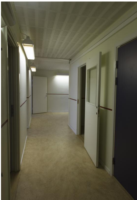
Rum 319, korridor med anslutande kontorslokaler, matrum till vänster samt toaletter och omklädningsrum till höger. SSMDIG024223.
