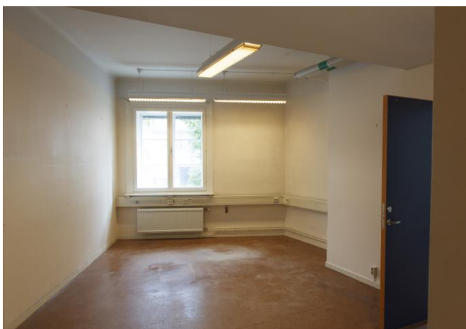
Rum 306, kontor/expedition. Exempel på samtliga rums utseende på våningsplanet. Interiören präglas av senare tiders moderniseringar av ytskikt och tekniska installationer. Dörrar och golvlister är sekundära. SSMDIG024224.
