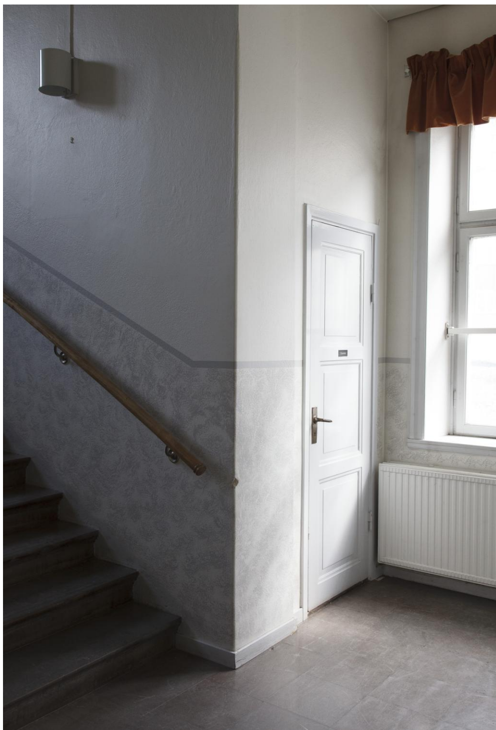
Rum 214, trapphall. Svampmålade väggar. Golven och trapporna av kalksten. Samtliga spegeldörrar i trapphuset är ursprungliga. SSMDIG024222.
