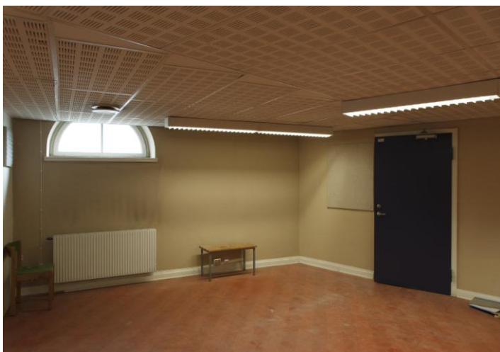
Rum. Exempel på samtliga rums utseende på våningsplanet. Delvis bevarade ursprungliga golvlister och dörrfoder samt ett lunettfönster med ursprungliga bågar. SSMDIG024247.
