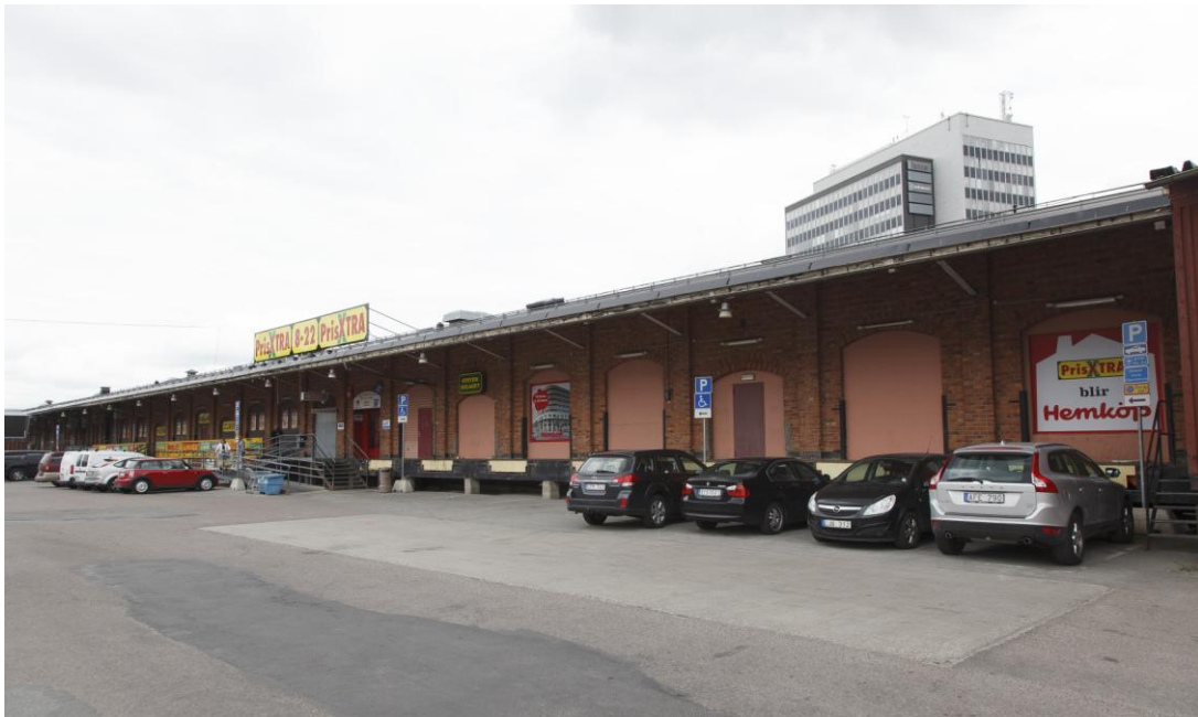
Norra godsmagasinet från nordväst. SSMDIG024256.
