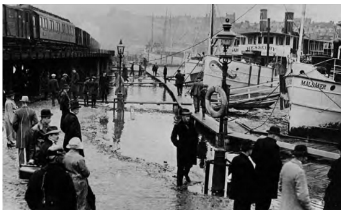
Översvämning från Mälaren vid Munkbrohamnen 1924. Foto: Stockholmskällan
