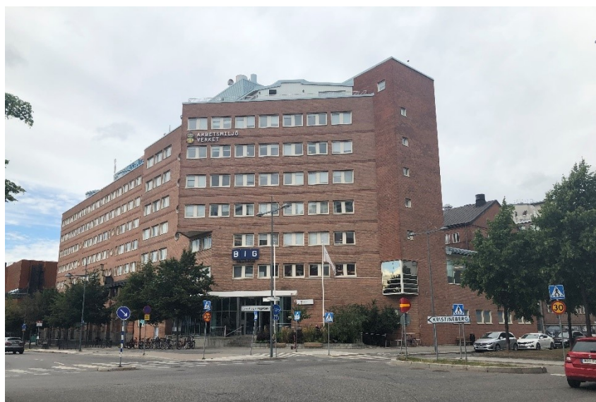
Fastigheten sedd från korsningen Nordenflychtsvägen – Lindhagensgatan (Tyréns).
