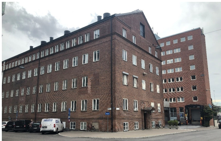
Fastigheten sedd från korsningen Lars Forssells gata - Lennngrensgatan. Penicillinfabrikens ursprungliga valmade tak ersattes under 1980-talet av en extra våning och ett sadeltak med gavelspets (Tyréns).
