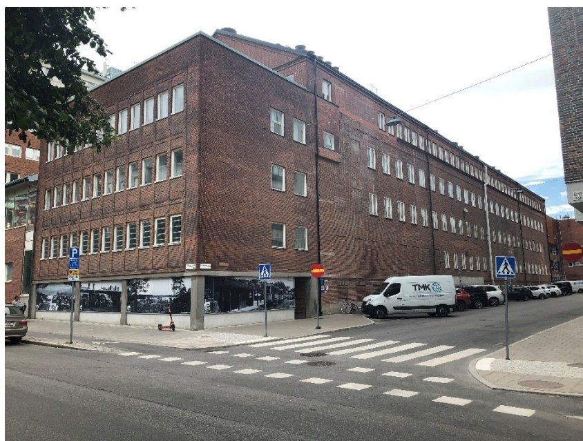
Fastigheten sedd från korsningen Lennngrensgatan – Lindhagensgatan (Tyréns).
