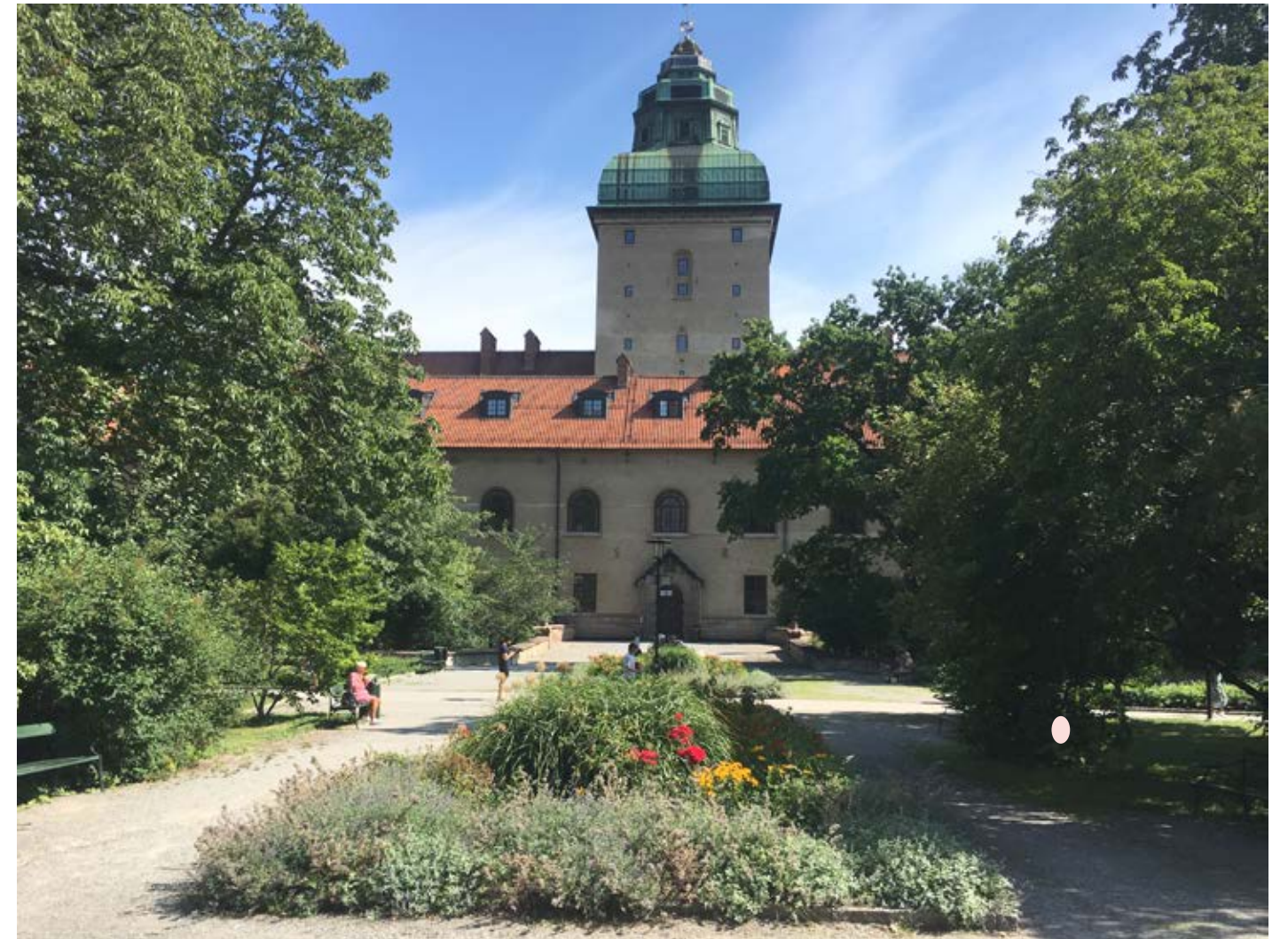
Parkens mittaxel mellan Polishuset och Rådhuset. Ytan kantas idag av parksoffor i mörkgrön kulör.
