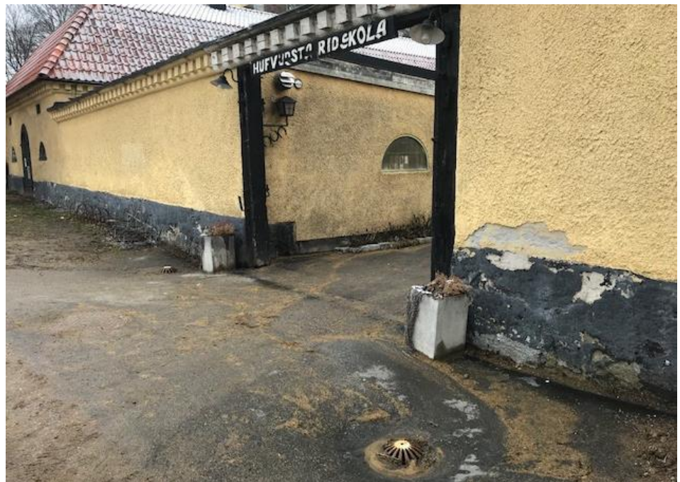
Bild 5. Entré till Huvudsta ridskola, Brunnarna på bilden leds till svackdike för rening innan avledning till Ulvsundasjön. Foto: Stina Thörnelöf
