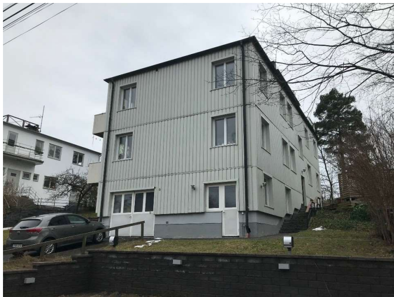
Fastigheten sedd från Norrskogsvägen, där den nedre våningen är tänkt att omvandlas till en ny lägenhet.
