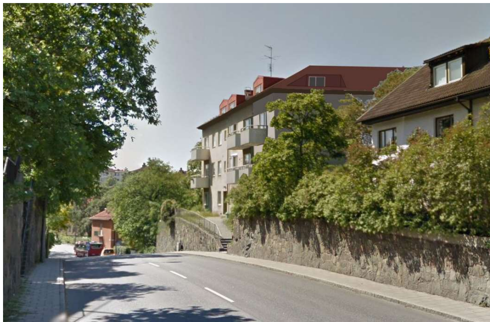
Bild efter ombyggnad mot sydväst längs med Badstrandsvägen.
