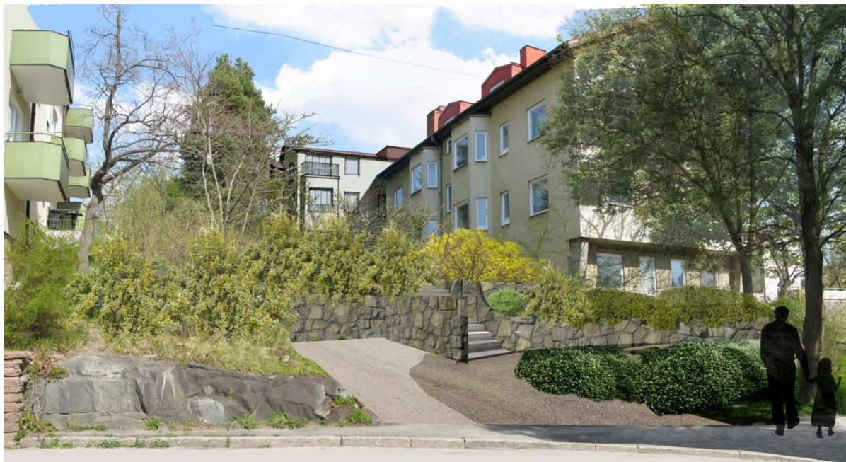
Bild efter ombyggnad och tillskapande av parkering, sedd från Tvätterskevägen.
