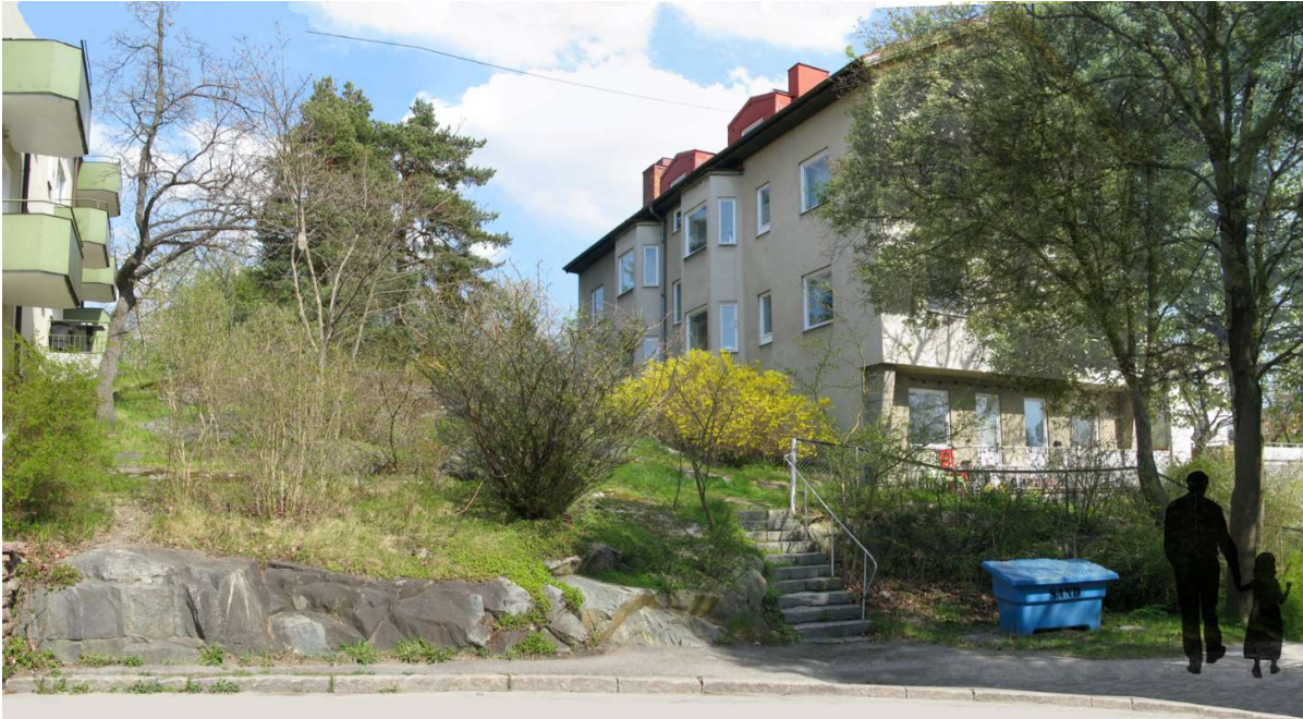
Bild före ombyggnad från Tvätterskevägen.
