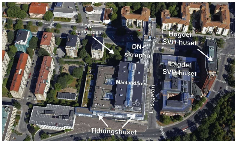
Befintlig bebyggelse inom Trängskåren 6 och 7.
