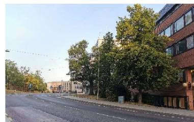
Kontorshuset inom Trängskåren 6 ligger nedsänkt i förhållande till gatan.
