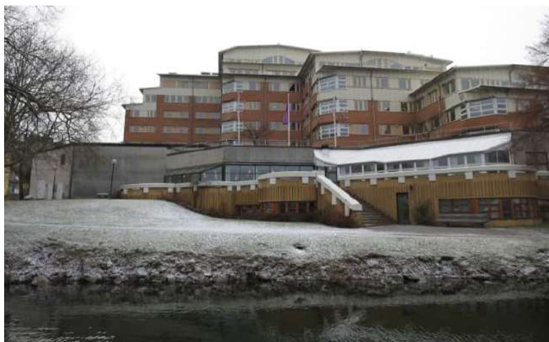
Lärarnas hus. Fasad mot vattnet.
