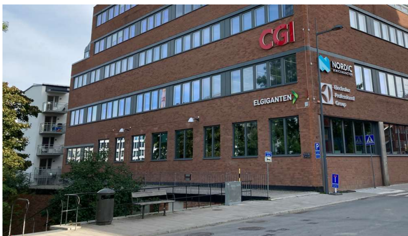
Takytan i väster mot Franzéngatan som idag används som gästparkering.
