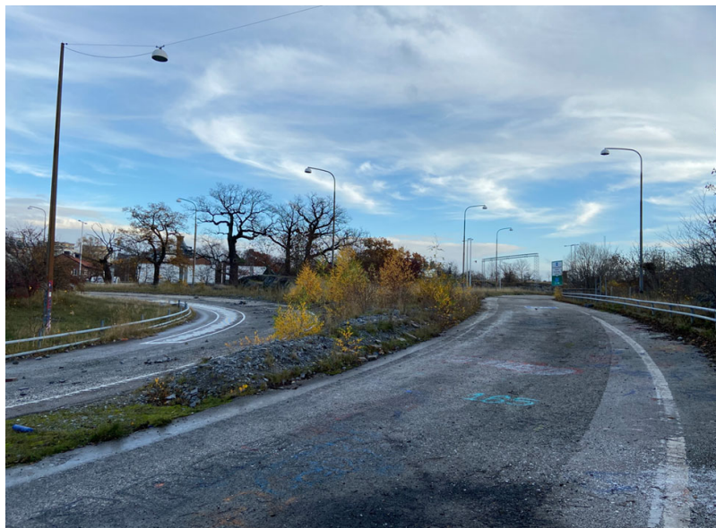
Del av tidigare på- och avfartsramp till Kristinebergs trafikplats. Foto: Stockholms stad
