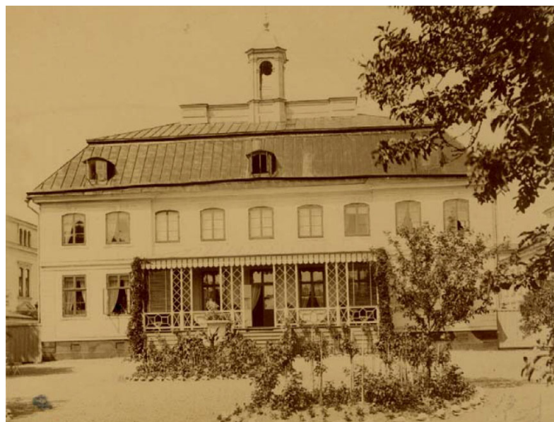
Huvudbyggnadens fasad mot söder och parken, med verandan från 1860-talets mitt. Foto omkring 1888, Fa 5627, SSM:s arkiv.
