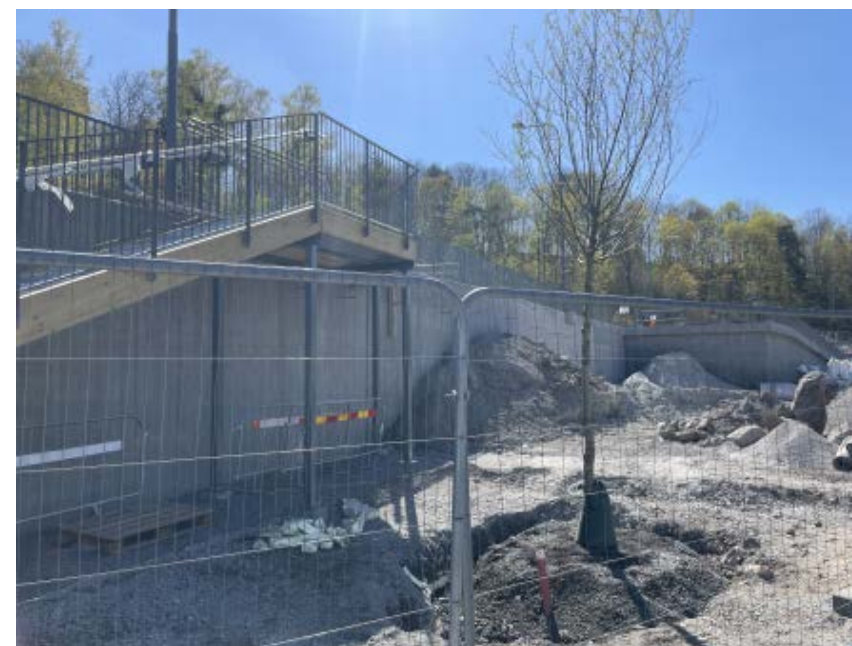
Bild 50. Ny trappa mellan strandstärket och Kungsholms strand under byggnation. Mars 2023.
