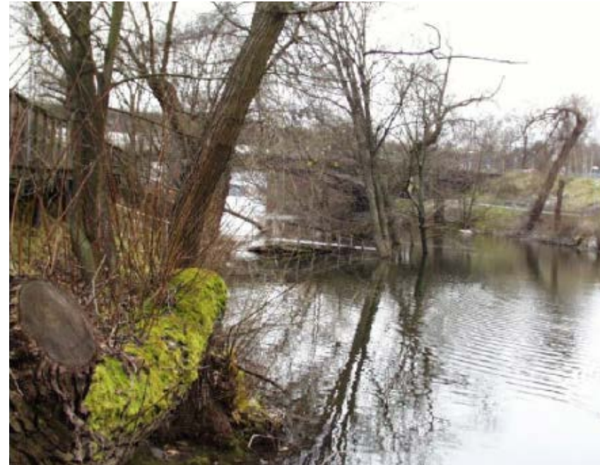
Bild 13. Foto från skred 2001. Träd och delar av bryggan kan ses ute i Karlbergskanalen. Bild från "Hornsbergs strand, Lilla Hornsberg, Kungsholmen. Geoteknisk utredning", 2002-02-22. Foto J&W
