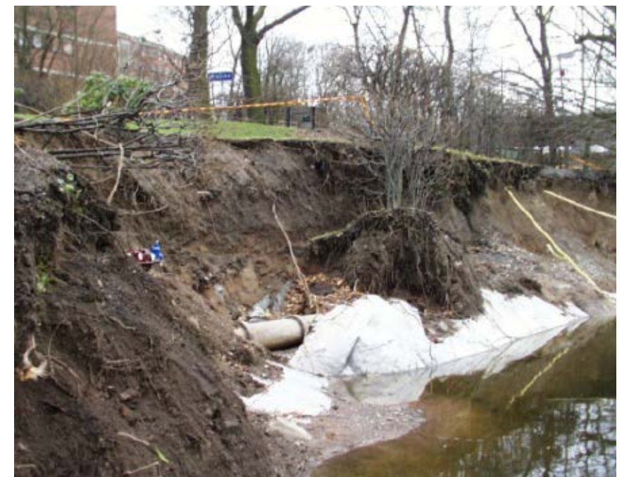
Bild 16. Foto från skred 2001. Skredområdet med blottlagda ledningar. Bild från "Hornsbergs strand, Lilla Hornsberg, Kungsholmen. Geoteknisk utredning", 2002-02-22. Foto J&W
