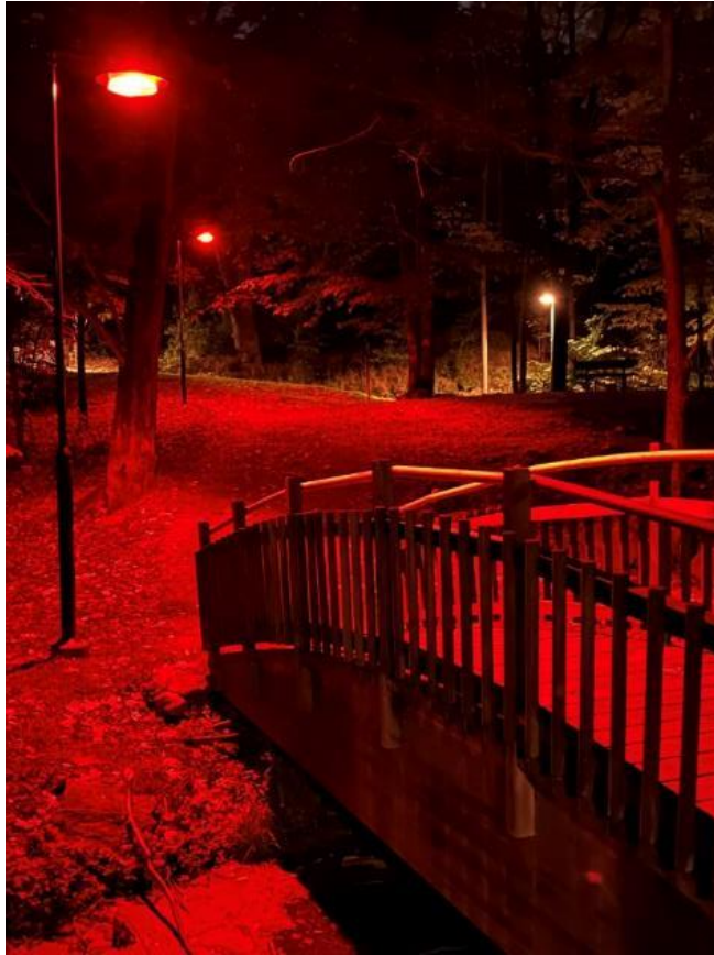
Foto: Med hjälp av närvarostyrning och färganpassning kan utomhusbelysningen ta hänsyn till flera fokusområden samtidigt. På bilden visas ett exempel från Årstaskogens naturreservat. När ingen människa passerar lyser belysningen med ett svagt rött sken som inte stör fladdermössen i området. När en person rör sig utmed gångvägen tänds ett varmvitt ljus. Foto: Mikael Ryberg.
