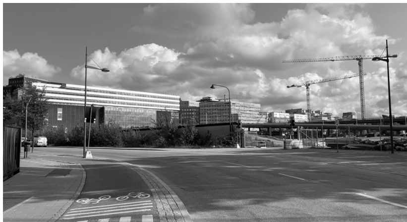
Befintlig mur utmed Nordenflychtsvägen och planområdet där bussdepån har rivits. (Stadsbyggnadskontoret)
