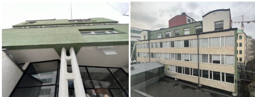
Bild 3 och 4. Byggnaden har ett indraget entréparti med dekorativa pelare. Långsidans fasader är klädda med eternitplattor.
