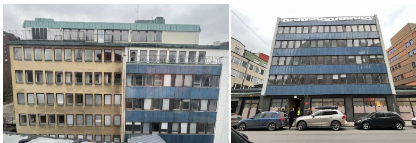
Bild 1 och 2. Långsidans fasad är uppdelad i en putsad del och en del med blåemaljerade plåtkassetter. Den översta våningen är indragen och klädd med koppertak.
