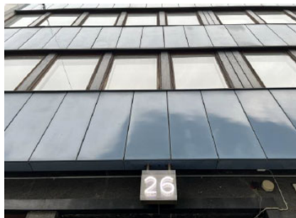
Bild 4 till vänster. Blåemaljerade plåtkassetter och fönsterband av teak. Bild 5 till höger. Ursprungligt trapphus med trappa och golv av kalksten, trappräcke av smide med handledare av lackat trä.
