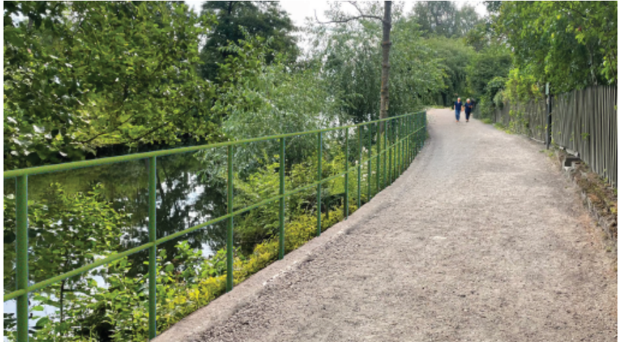
Figur 15. Fotomontage som visar det föreslagna påldäcket längs kolonilottsområdet. Påldäcket ser ut som en vanlig gångväg med ett slitlager av stenmjöl och räcke av stål.
