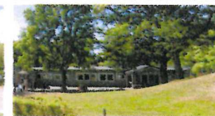
Förskola och skola Mogårdsvägen
