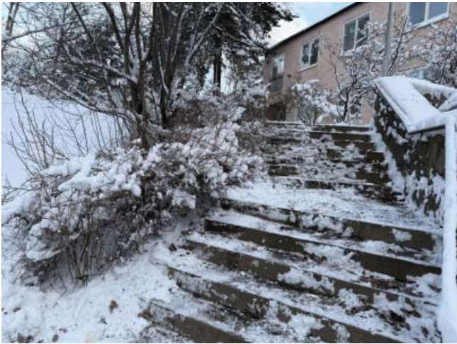
Utvändig trappa upp mot gård och entréer
