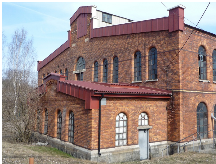
Vattengasverkets västra fasad.
