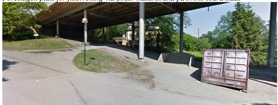
Föreslagen plats för filterrening eller växtbädd vid Smedsuddsvägen på Västerbrons norra sida.
