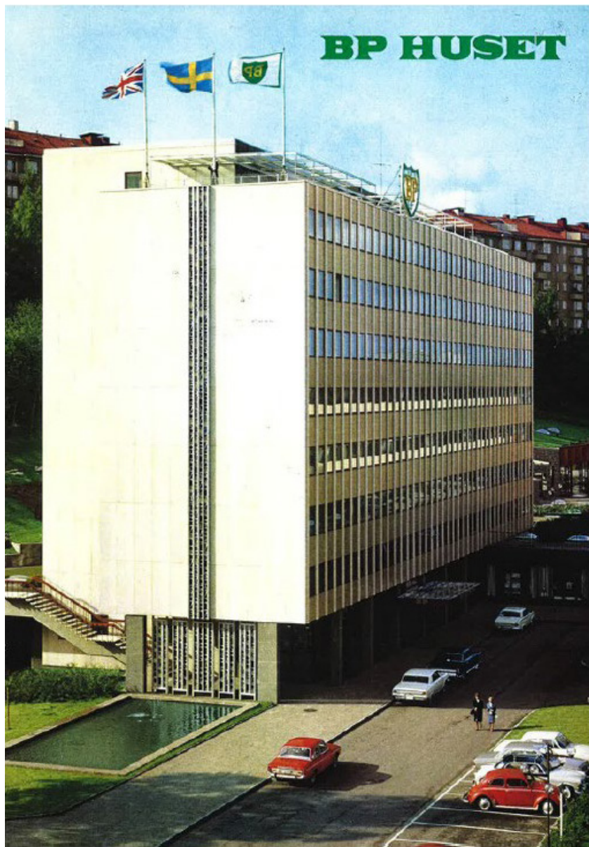
Framsidan på skriften BP-Huset där Svenska BP presenterade sin nya byggnad. Notera utformningen av taket med takterrass och dammen vid gaveln. Taket är numera ombyggt och dammen igenlagd. Ur BP-Huset.
