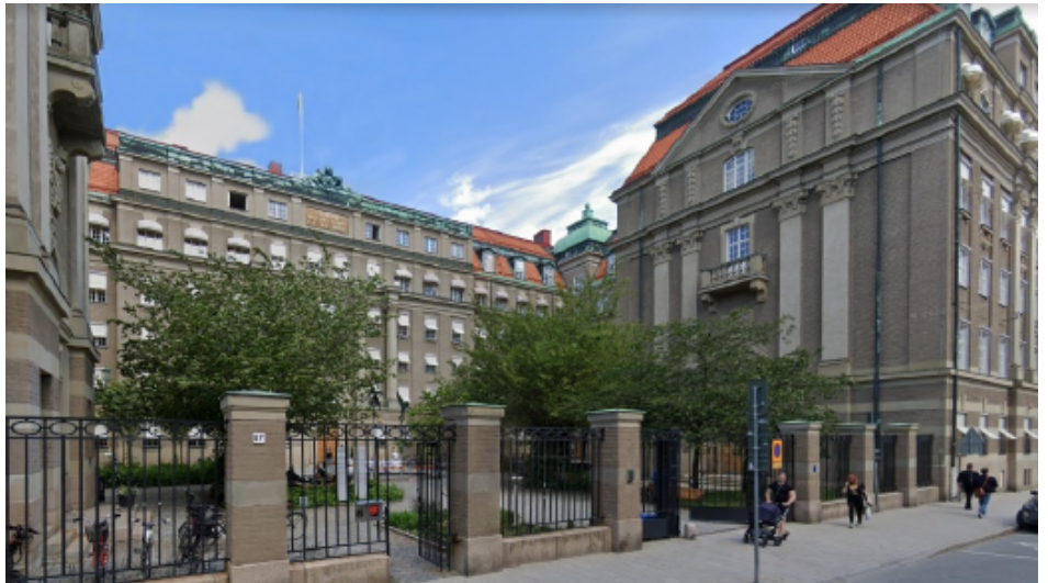
Vy mot innergårdsmiljö samt huvudentré på aktuell fastighet, Uppfinnaren 2, Östermalmsgatan 87.
