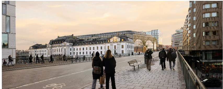
Den befintliga stationsbyggnaden framför det nya stationskvarteret sett från Klarabergsviaduktens bro över Vasagatan. Bild: Marge Arkitekter
