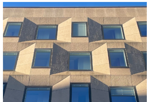
Vänster foto: Bottenvåningens fasad mot Malmskillnadsgatan med polerad yta. Höger foto: Byggnadskroppens fasad med finhuggen yta. (Tyréns)
