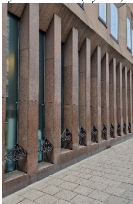
Vänster foto: Bottenvåningens fasad mot Malmskillnadsgatan med polerad yta. Höger foto: Byggnadskroppens fasad med finhuggen yta. (Tyréns)
