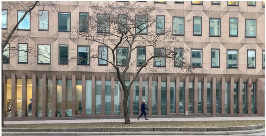
Foto: fasad mot Malmskillnadsgatan som visar skillnaden mellan bottenvåningens och ovanliggande fasads materialitet och yta som skapar en nyansskillnad. (Tyréns)
