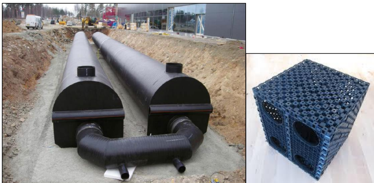
Figur 5–3. Fördröjningsmagasin i plast, i form av rörmagasin (vänster) och plastkassetter (höger).
