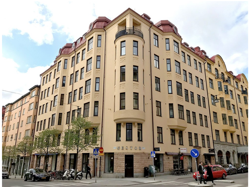
Befintligt gathus inom fastigheten Sjölejonet 3.
